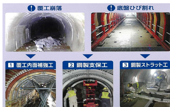
図-4 右第2水抜き坑の補強工事
