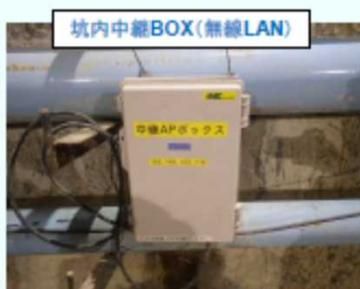
ネットワークカメラを切羽照明機(切羽から約25m)に設置し、坑内中継BOX(無線LAN)でインターネット接続して坑外で作業の確認ができる
