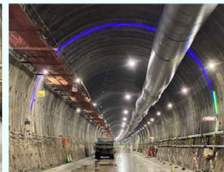
トンネル坑内の設備やTD表示を見やすく・分かりやすくするためにLED(回転灯・チューブライト)を設置しました。LEDは高輝度で視認性がよく、製品として色のパリエーションも豊富で、設備との接触防止や通路等の明示に有効です。
