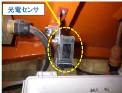
拡散反射型光電センサ
