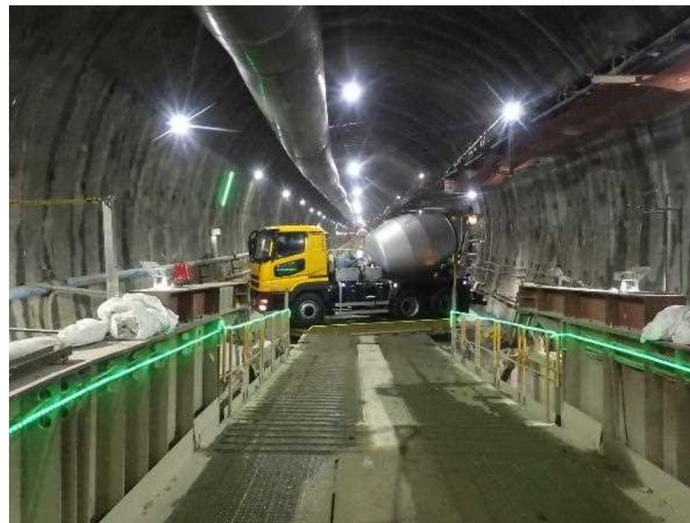
インバート棧橋とターンテーブルを連結することで生コン車移動距離が飛躍的に短くなり安全かつ生コン車の入替時間が大幅に短縮される！
