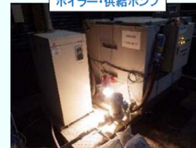
ボイラー→ボイラータンク→水槽を循環させることにより水温を上昇させています。水槽には投げ込みヒーターも設置しており、水温が下がらないようにしています。
