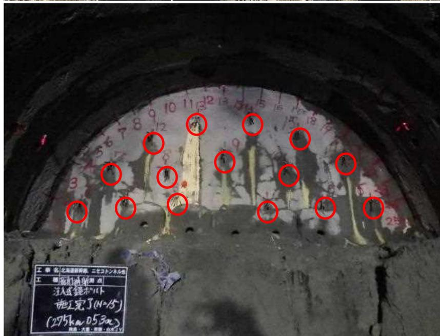
地山状況、地上部の対象物に応じての鋼管（ $L=12.5\text{m}$ ,  $\Phi 89$ ）をシフト長：**9m** → 鋼管（ $L=9.5\text{m}$ ,  $\Phi 89$ ）シフト長：**6m**, 打設本数：**5本** → **18本**にグレードを変えることで最適な補助工法の選定を行った。
