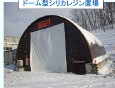
支保工を建て、キーストンで囲うことにより、雨・風・雪の影響を最小限に抑えるようにしました。入口部をカーテンで閉め、ドーム内温度を一定にしています。
