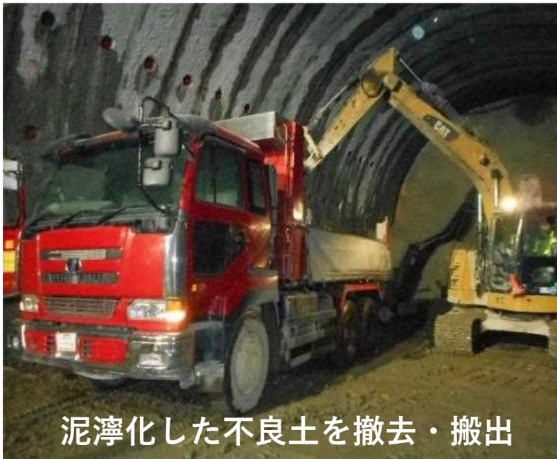
泥濁化した不良土を撤去・搬出
