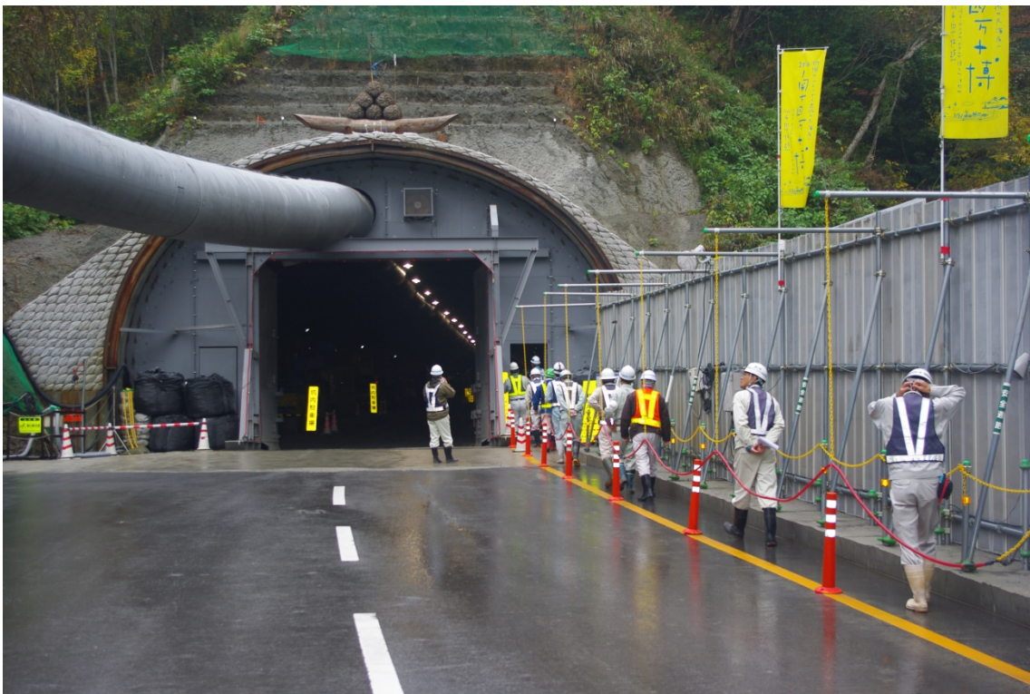
坑口ヤードの見学状況
