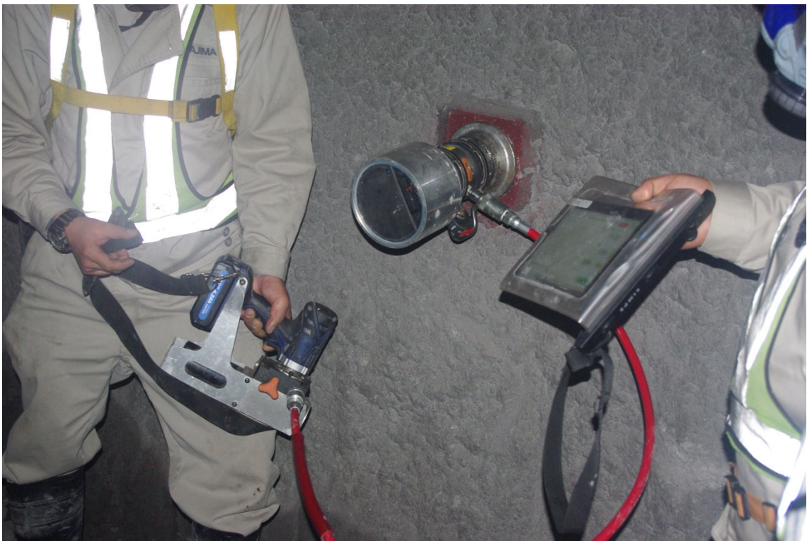
新ロックボルト引き抜き試験機のデモ
