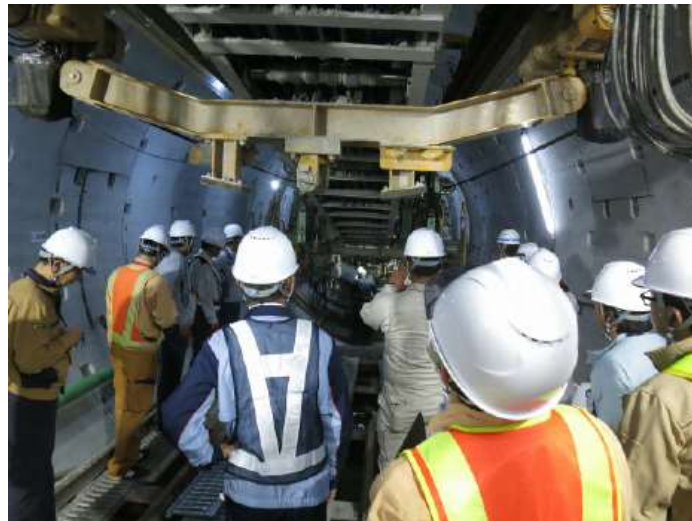
シールドトンネル内
