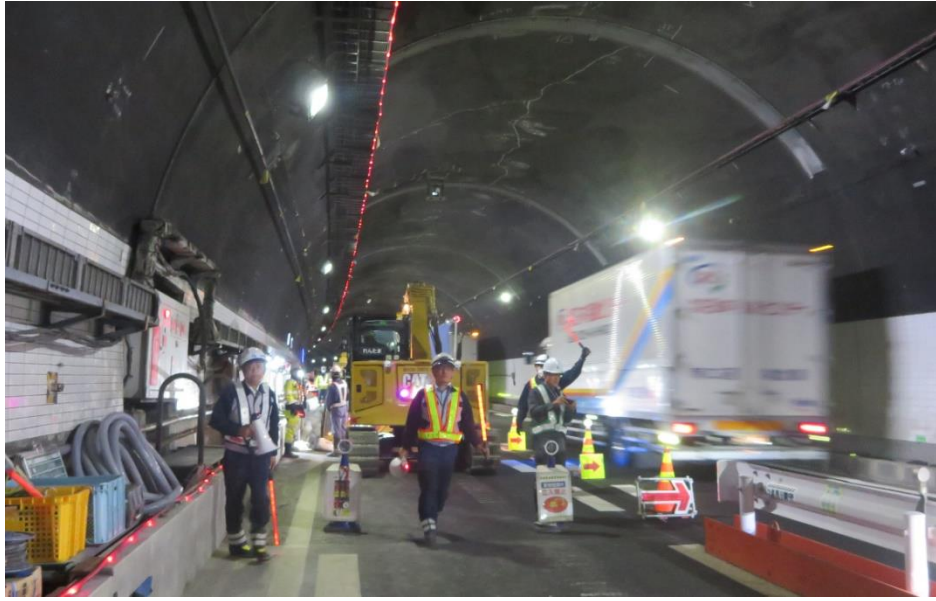
(工事現場のすぐ脇をトラックが走行している)
