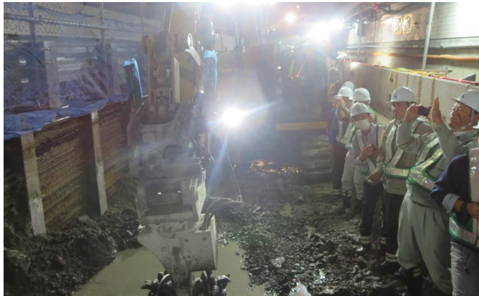
(狭い作業空間での掘削作業状況)
