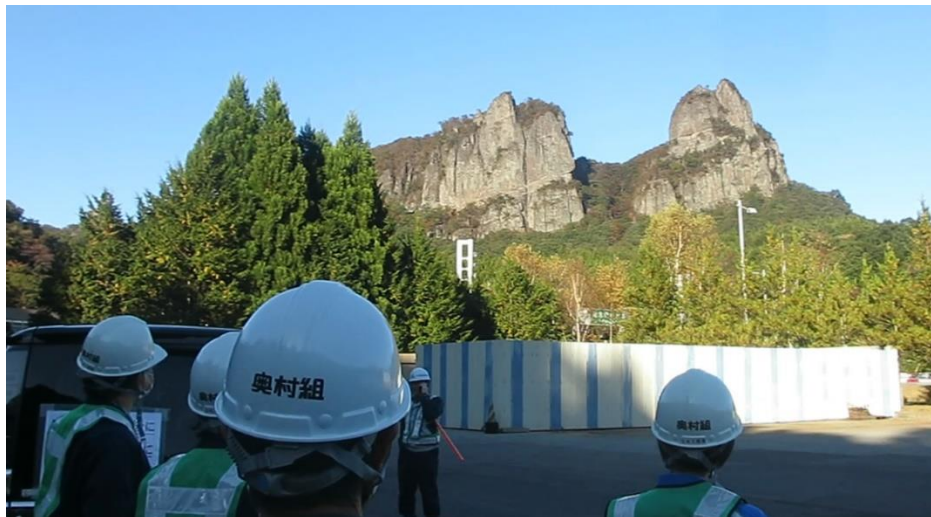
(高岩山トンネルの外観。特徴的な形状をしている。)
