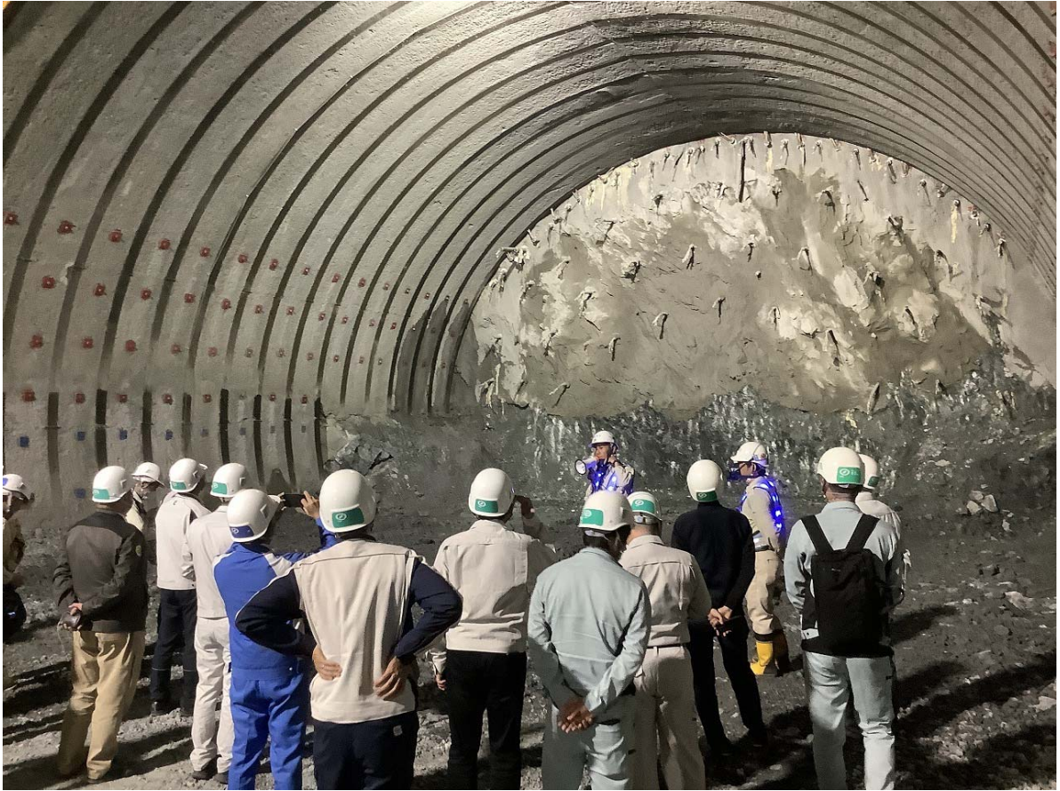
清水建設の山本所長による現場説明
